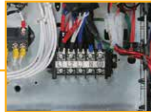
Dış ünite güç besleme terminal bloğu
