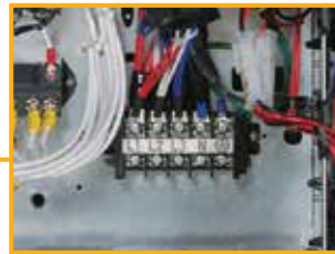
Dış ünite güç besleme terminal bloğu
