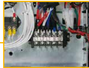
Dış ünite güç besleme terminal bloğu
